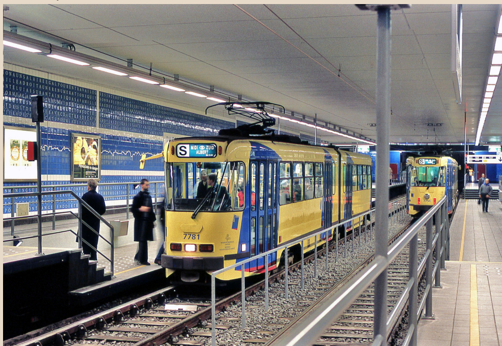
Les motrices ayant participé au cortège inaugural avaient été équipées d'une mention spéciale. Après le voyage protocolaire, elles ont permis aux clients de découvrir les nouvelles infrastructures. La 7781 croise la 7750 dans la station Parvis de Saint-Gilles. © M. Reys.
