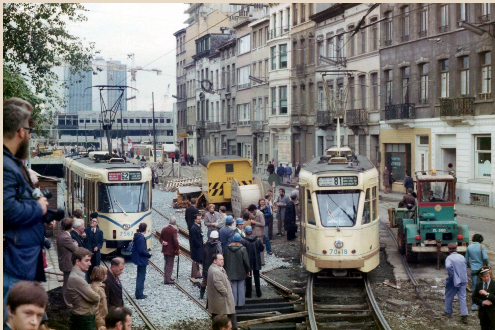
Quelques instants avant les travaux de pose de la voie vers le tunnel Nord-Sud, celle sortant étant déjà raccordée à la rue du Progrès, la 7018 de la ligne 81 en direction du Heysel a encore parcouru les boulevards centraux en surface tandis que la 7567 ayant participé au voyage inaugural dans le prémétro attend de s'engager en surface. 04.10.1976. © collection Mupdofer
