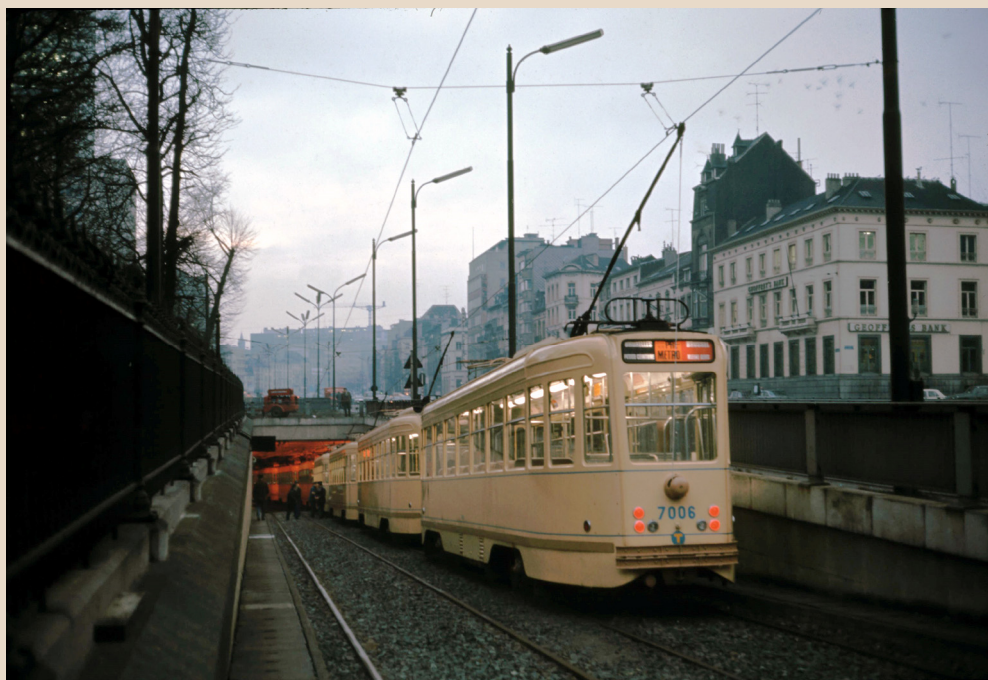
Plusieurs motrices ont été affectées au cortège inaugural du premier tronçon de préméto sous la Petite Ceinture. La 7006, dernière de la file (?), attend de s'engager dans le tunnel et est immobilisée dans la trémie du square Henri Frick. 21.12.1070. © J.-M. Pholien.
